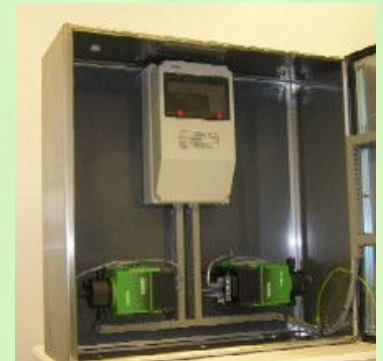
Abb. 1: DuoSept Pumpenstand mit Steuerungseinheit (Duosept Autodes ID)
